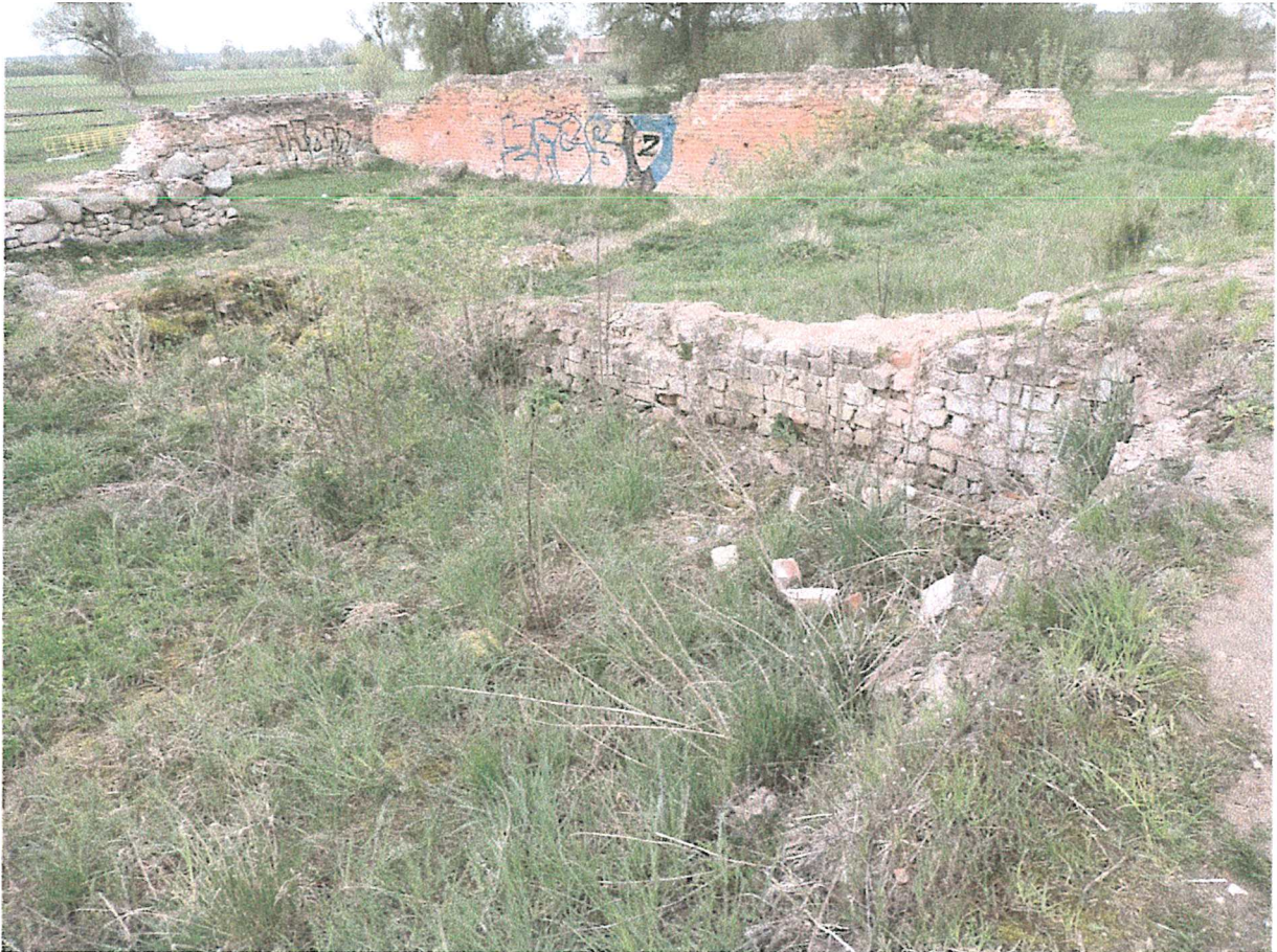
9. Wnętrze zamku, widok w kierunku południowo zachodnim.
