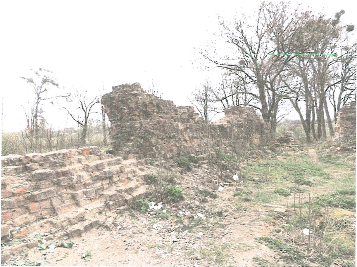
8. Wewnętrzna część muru wschodniego.
