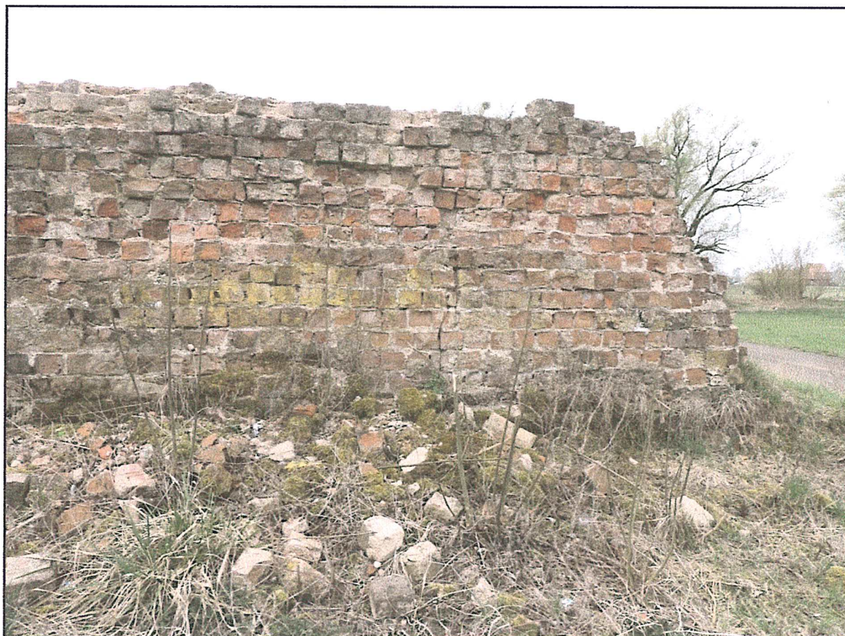
2. Gruz zalegający pod murem północnym.
