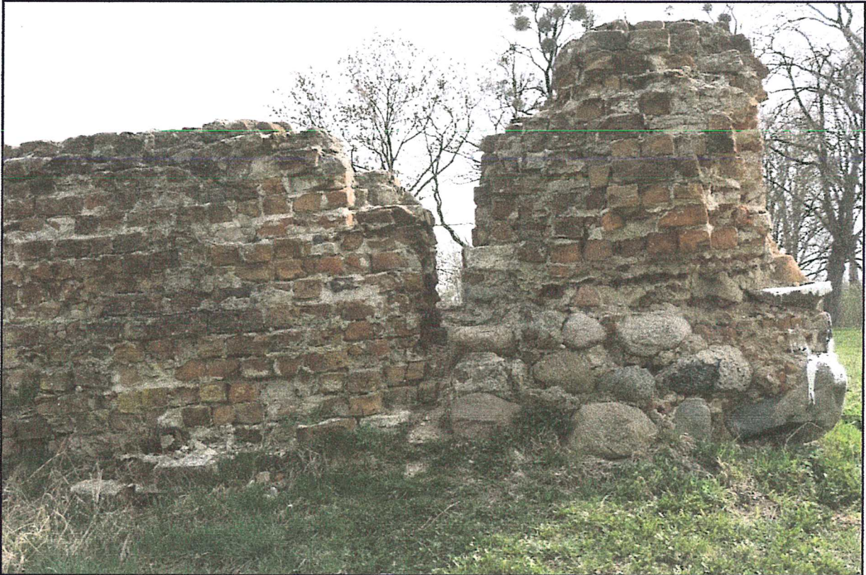
4. Narożnik południowo zachodni. Nie proponuje się wypełniania szczeliny nowym wymurowaniem, ponieważ obie ściany zamku w obecnym stanie są stabilne.
