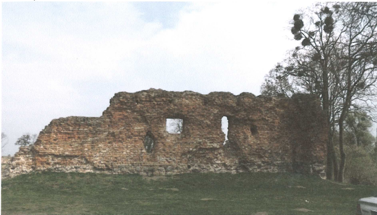
1. Ściana południowa zamku.
