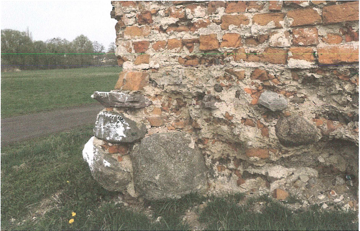
12. Narożnik południowo zachodni wymagający podmurowania. Widoczne pasy gruzu ceglanego w murze kamiennym.
