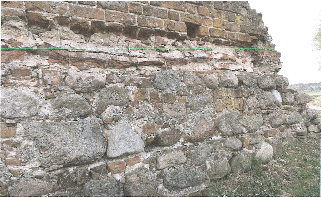
14. Kamienny mur rzędowy, powyżej fragment zachowanego lica ceglanego.
