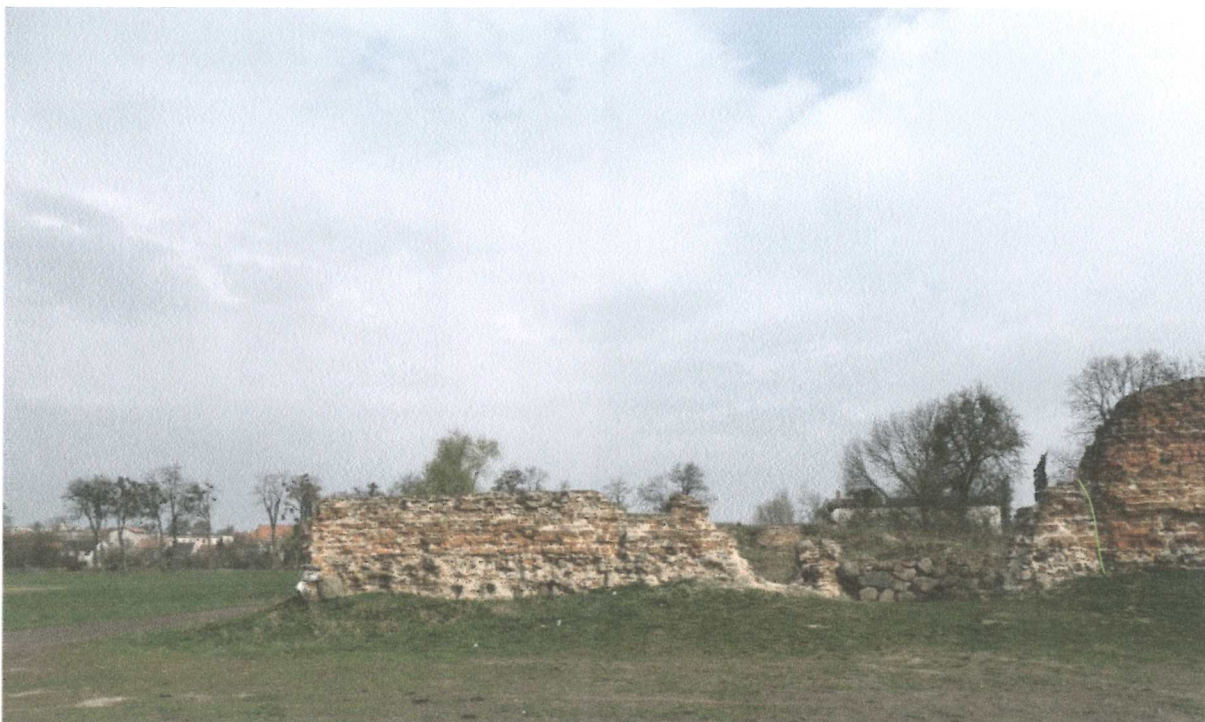
3. Ściana południowa zamku, kraniec zachodni. Zieloną linią oznaczono pęknięcie muru.
