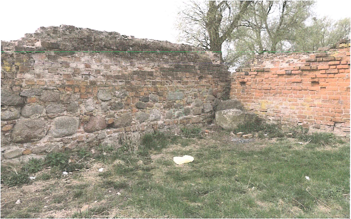
16. Narożnik południowo zachodni, strona wewnętrzna.
