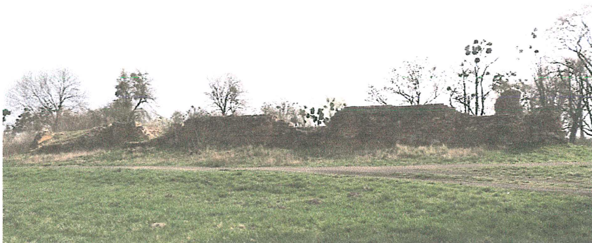
1. Mur zachodni, strona zewnętrzna.
