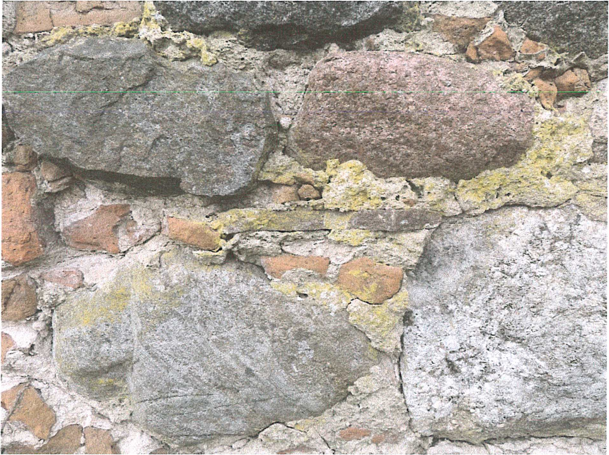
18. Porosty zasiedlające mury zamku.
